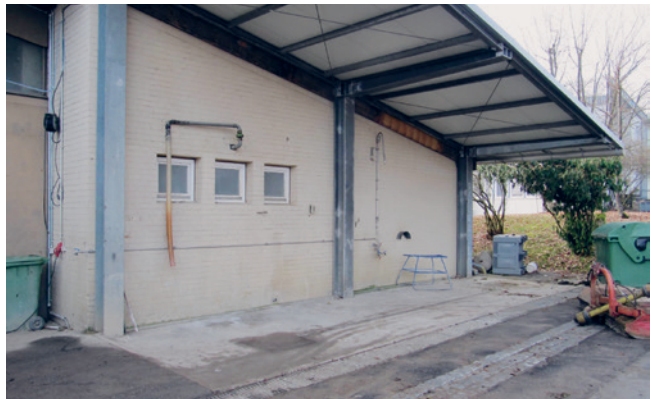
Platz zum Befüllen der Spritze: Überdachter Betonplatz mit Auffangrinne sowie praktischem Schlauchgalgen, B. Arnold.
